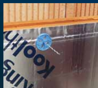
indraaien UNI-Bouwsouwanker m.b.v. Indraaihulpstuk
