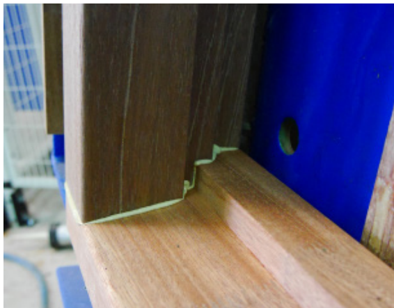
Figuur 3. De lijm wordt naar buiten geperst.
